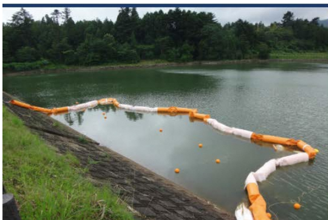
シルトフェンスによる取水の管理
