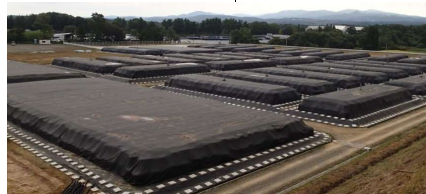
除去土壌等仮置場保管の例
