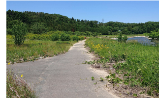
↓被害を受けた河川敷
