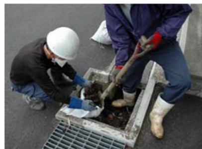
側溝堆積物の除去
