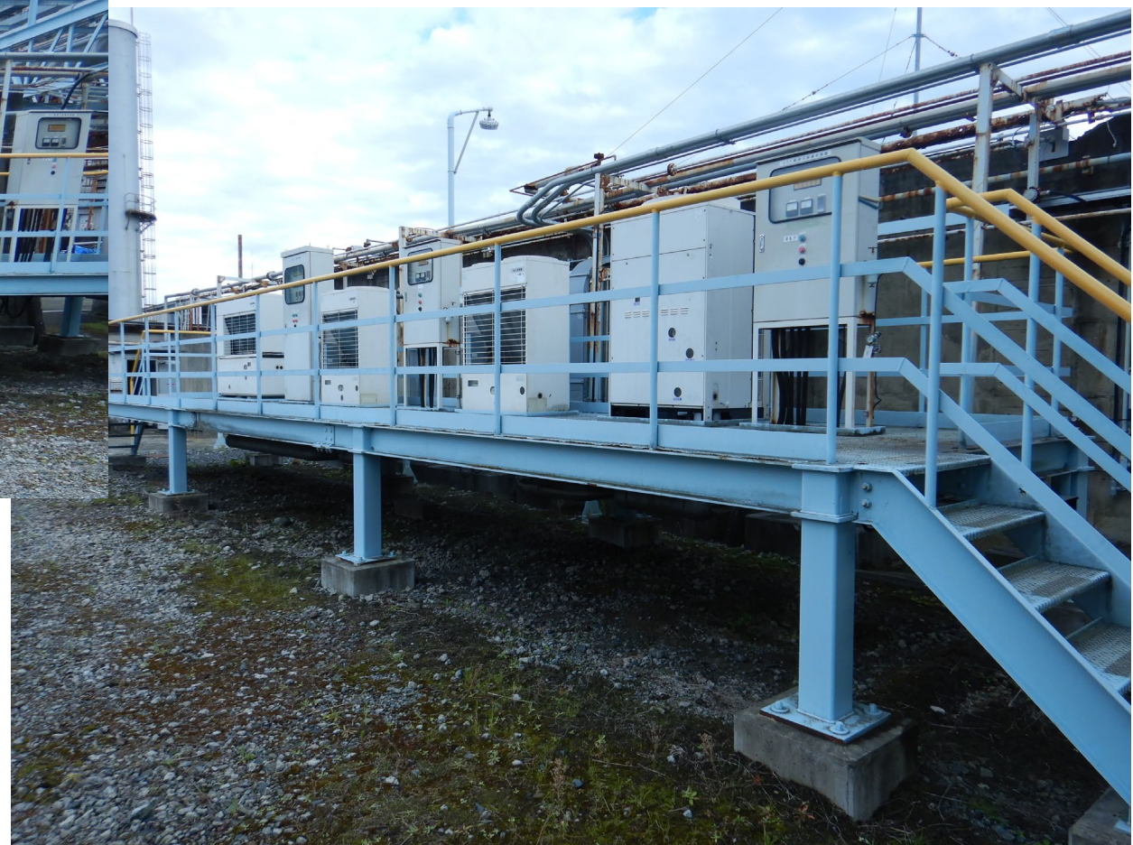
触媒冷凍庫の電気設備の高所移設
