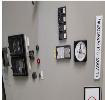
東側、南側高圧盤側面浸水跡(約20cm)
