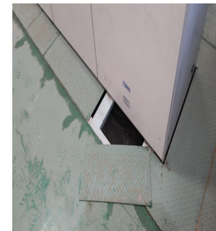
北側低圧L/C盤下ビッド下水満水
