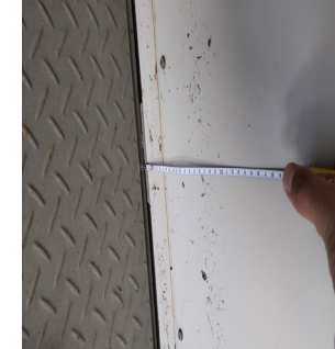
東側、南側高圧盤側面浸水跡(約20cm)
