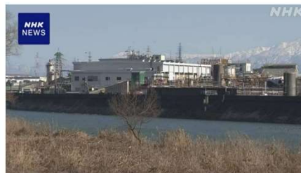
富山 高岡の化学工場 地震で破損 一時 塩酸処理水が川に流出
