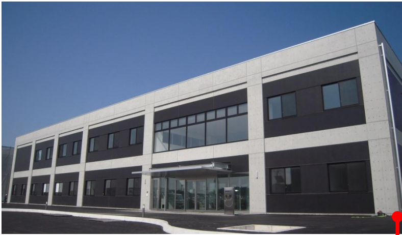
環境創造センター本館（三春町）
