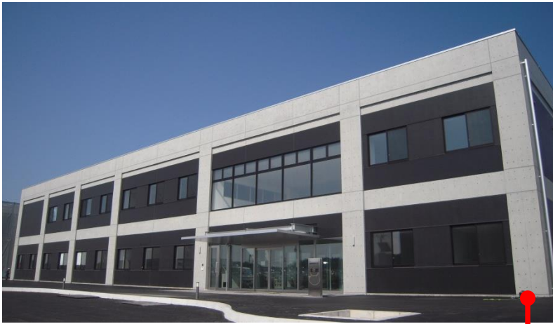
環境創造センター本館（三春町）
