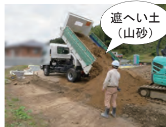
図1 原状回復作業の例（左：碎土・深耕、中央：客土、右：耕起）
