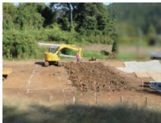
図1 原状回復作業の例（左：碎土・深耕、中央：客土、右：耕起）
