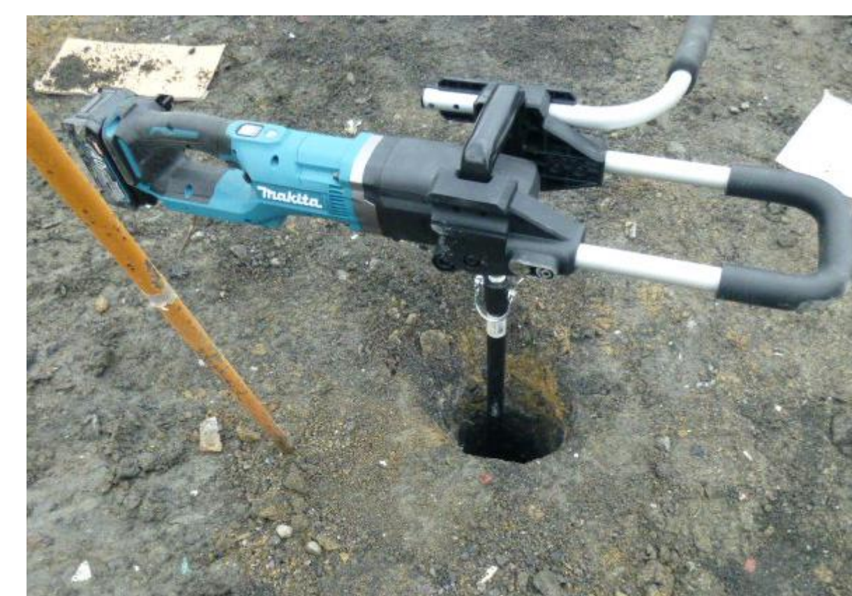
図2 ドリルによる穴掘り
