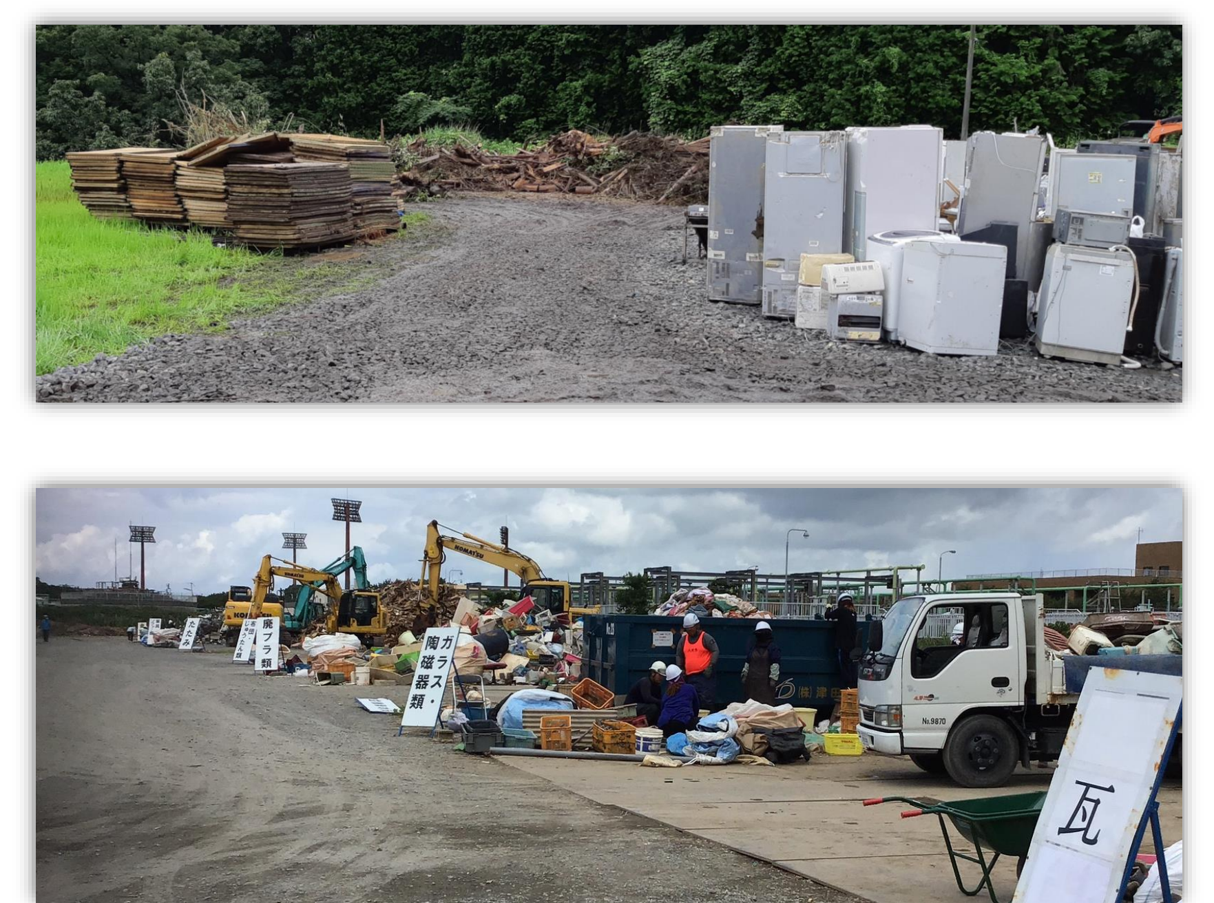
仮置場に品目別に配置されている災害廃棄物
