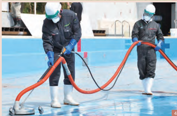
1 | 2011年4月27日 土木業者の方による表土除去の様子 2 | 2012年7月11日 芝生除去後の張替え 3 | 小学校の除去土壌等の掘り起し 4 | 2012年4月25日 プール底を吸引式高圧洗浄機で除染 写真提供 | 福島県郡山市
