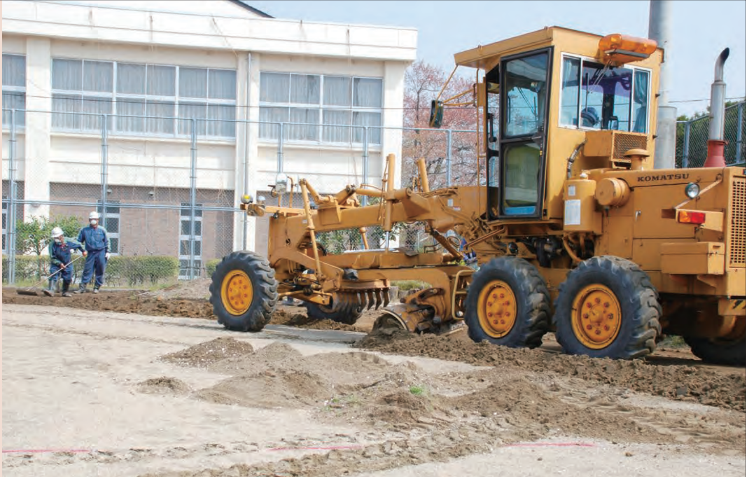
2011年4月27日 表土除去作業 写真提供 | 福島県郡山市
