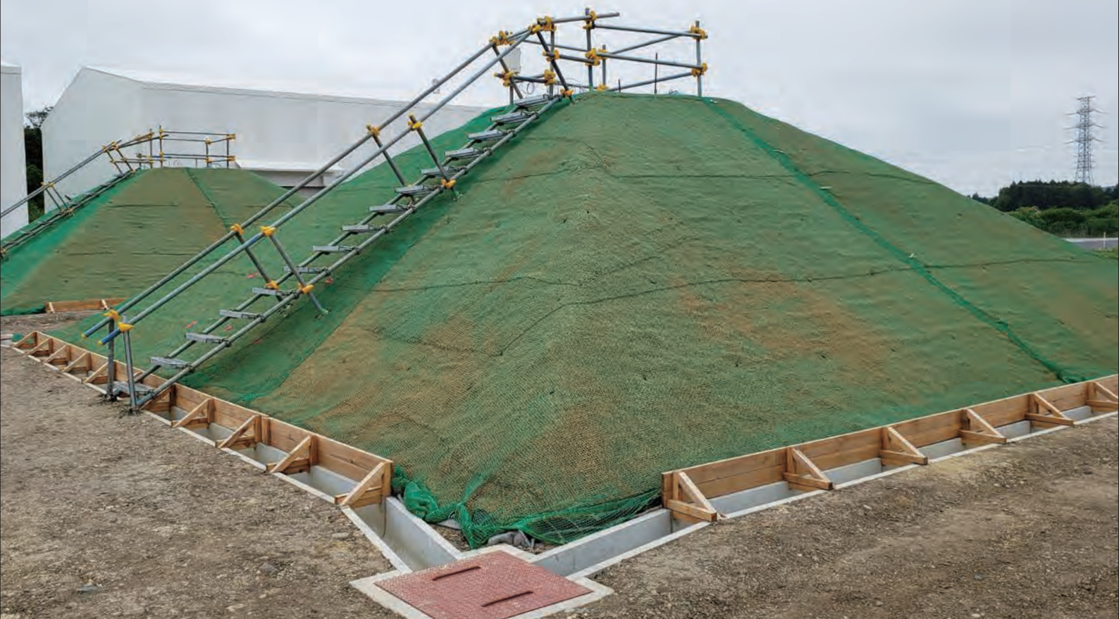
技術実証フィールドで構築された実験盛土
