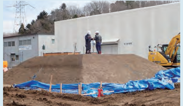
技術実証フィールドで 構築中の実験盛土
