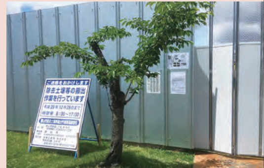
2017年6月4日 郡山市開成1丁目地区除去土壌詰替場 ※詰替場とは、集約輸送の拠点である積込場に運び込む前に、各住宅から出した除去土壌を大型土のうに詰め替える場所
